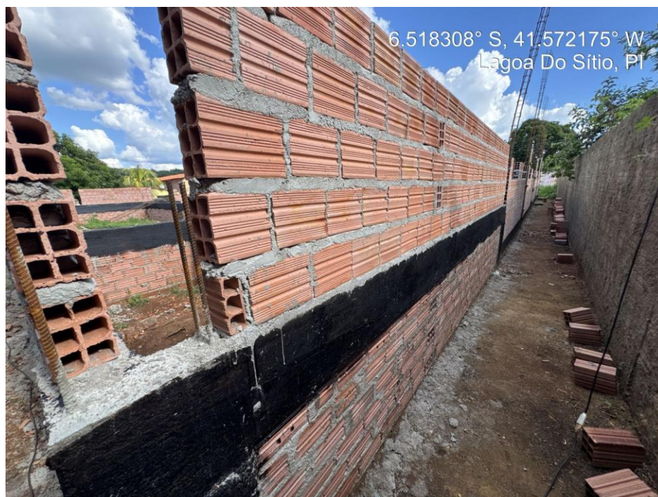
Figura 3 - Fachada lateral direita
