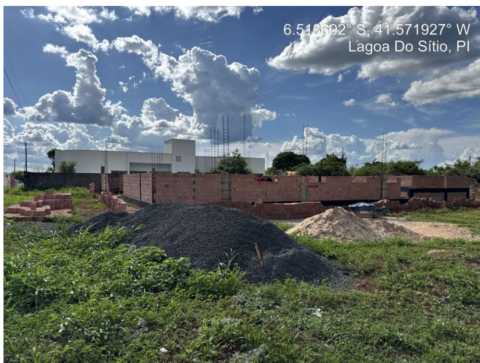
Figura 2 - Fachada lateral esquerda
