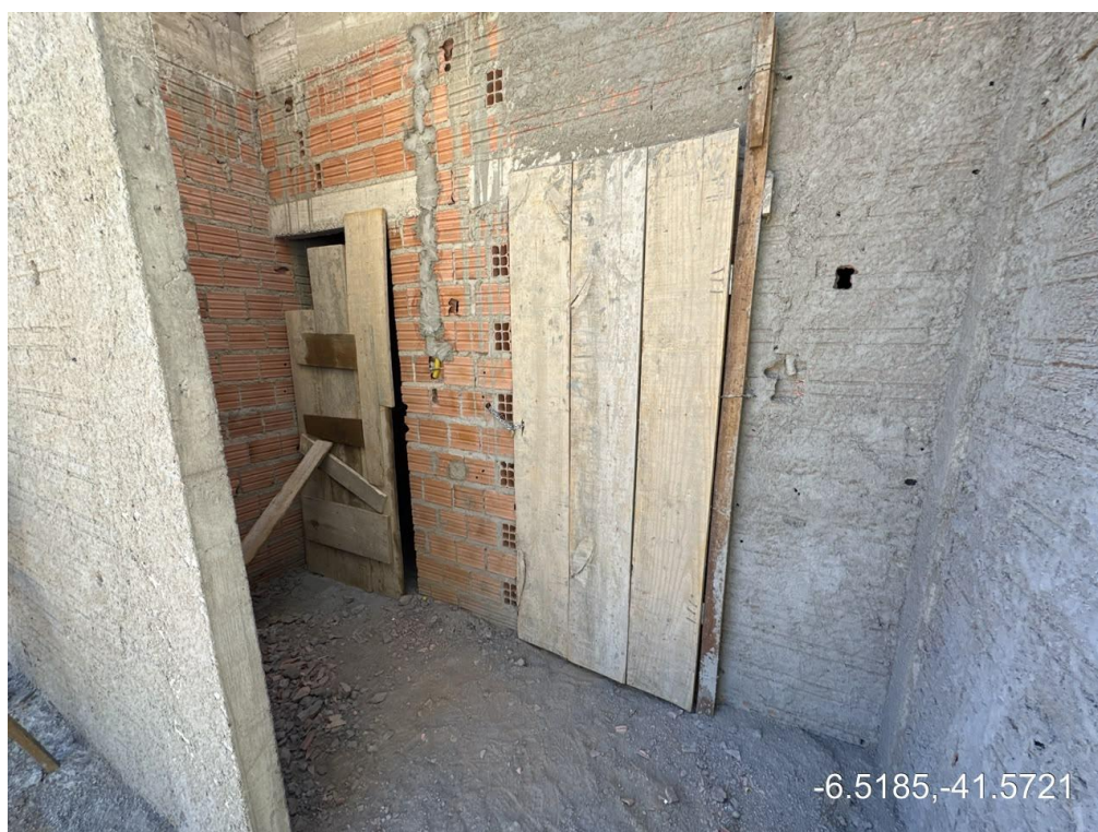
Figura 12 - Hall e banheiros masculino e feminino
