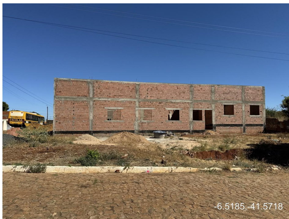
Figura 2 - Fachada lateral esquerda
