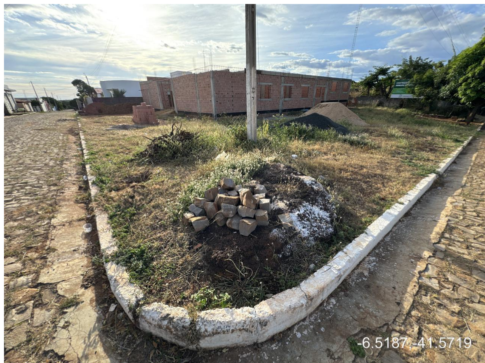
Figura 2 - Fachada lateral esquerda
