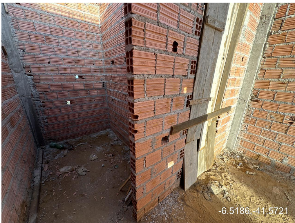
Figura 12 - Hall e banheiros masculino e feminino
